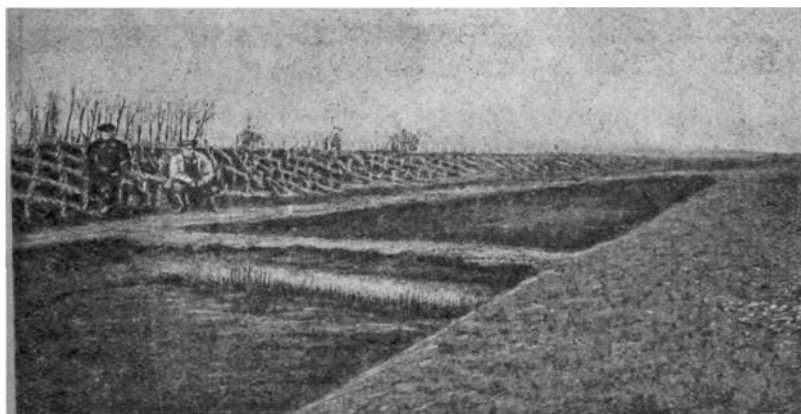
Цивильская дамба на тракте Цивильск—М.-Посад объемом 15 000 м 3 , построена трудучастием в 1930 г. Откосы укреплены плетеньями клетками с заброской камнем.
