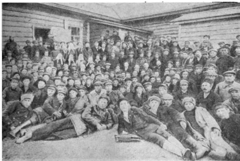
1 Батыревский район—слет ударников дорожного строительства.
