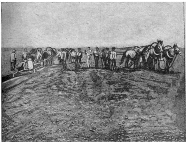
Работа с канавокопателем.
